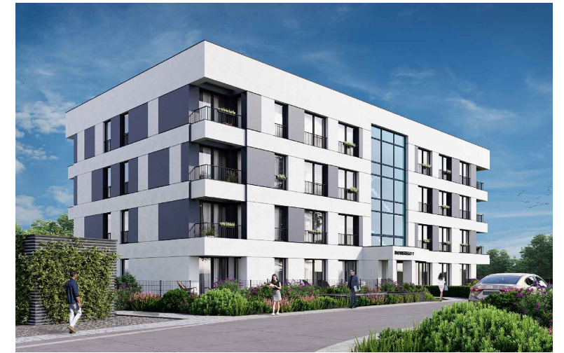
BUDYNEK WIELORODZINNY UL. BADURSKIEGO 7
